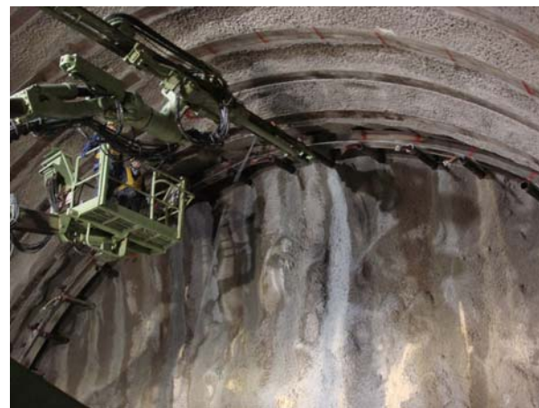
補助工法（多段式長尺鋼管フォールディング）
