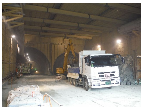
ずり出し状況（坑内）
