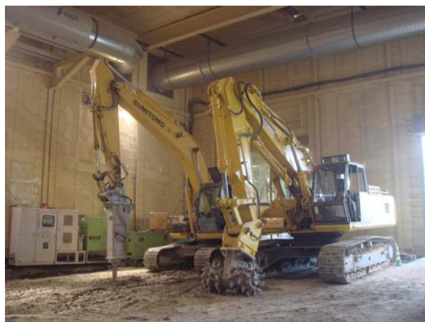
トンネル掘削機械
